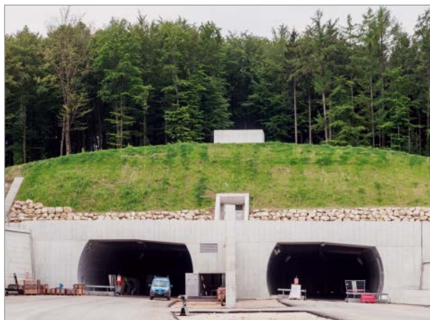
Bild 1: Ansicht des Portalbereichs vom Tunnel Längholz
