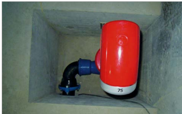
Bild 13: Eingeengte Platzverhältnisse für die Installation der Hydranten
