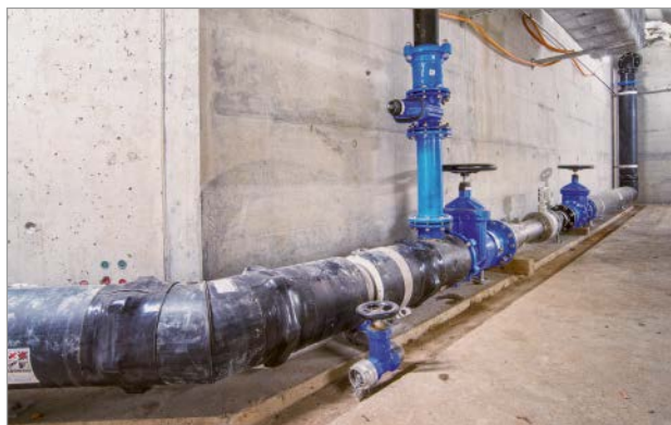
Bild 15: vonRoll Armaturen im Einsatz – Streckenschieber, Absperrschieber für Stichleitungen sowie Anbohrarmatur zur Entleerung
