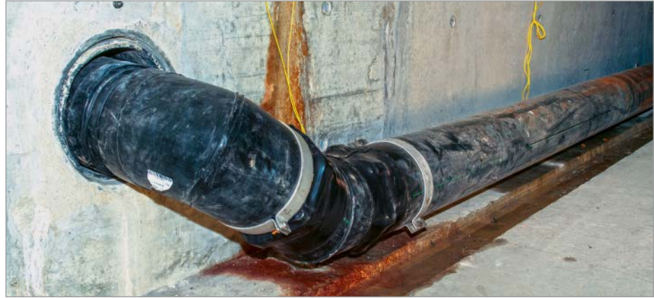
Bild 7: Nachdämmung mit Schrumpfmanschetten an den Verbindungsstellen der Steckmuffen
