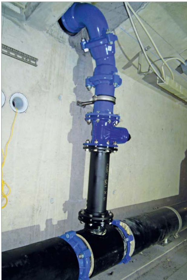
Bild 11: Stichleitung DN 125, einfach ausrichtbare Formstücke mit außenliegenden Schubsicherungen Fig. 2806
