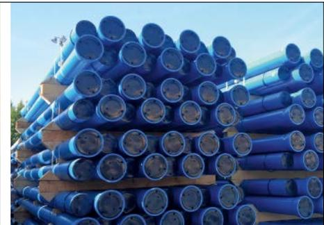
Stapelhöhen duktiler Gussrohre sind den Herstellerangaben zu entnehmen. Stapelhöhen auf der Baustelle > 3 m sind aus Sicherheitsgründen zu vermeiden.
