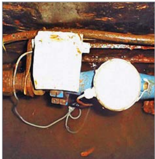
Fernauslesbarer Wasserzähler
