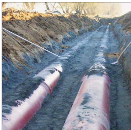
Bild 9.41: Paralleleinbau von duktilen Abwasserdruck- leitungen DN 600 mit BRS® / TYTON SIT PLUS® - Steckmuffen-Verbindungen
