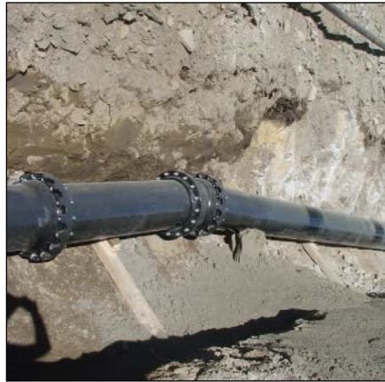
Bild 9.45: Turbinenleitung DN 400
