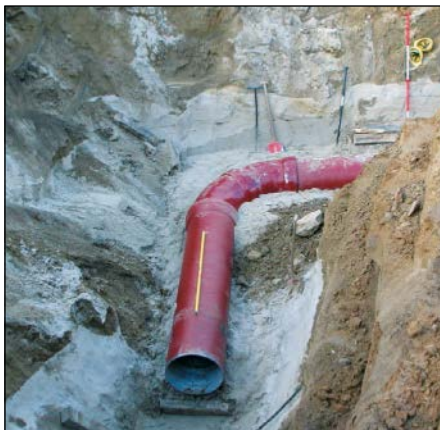
Bild 9.40: Duktile Kanalrohre DN 700 mit Steckmuffen-Verbindungen Novo SIT®
