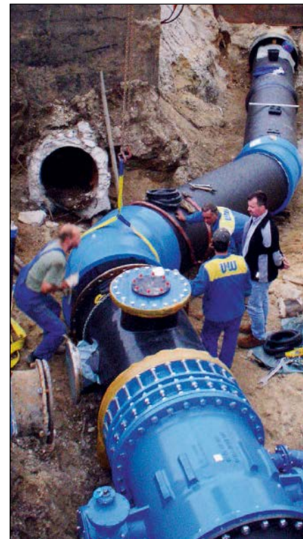
Bild 9.42: Einbau von duktilen Bögen in längskraftschlüssiger Ausführung
