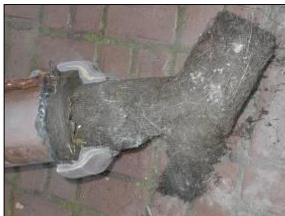
**Abb. 10:** Wurzelpolster im Abweig einer Regenwasserleitung. Der Abweig wurde teilweise entfernt. Die Wurzeln bilden ein dichtes Polster auf der Sohle der Leitung, welches die Form des Abzweiges abbildet
