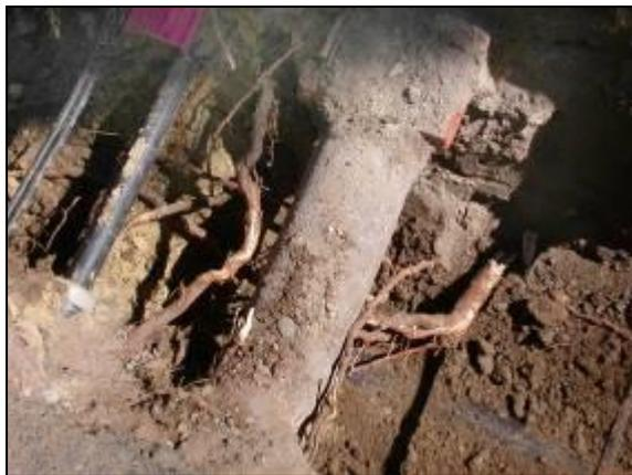
**Abb. 7:** Wurzeln haben sich im Bettungsmaterial von Versorgungsleitungen ausgebreitet.
