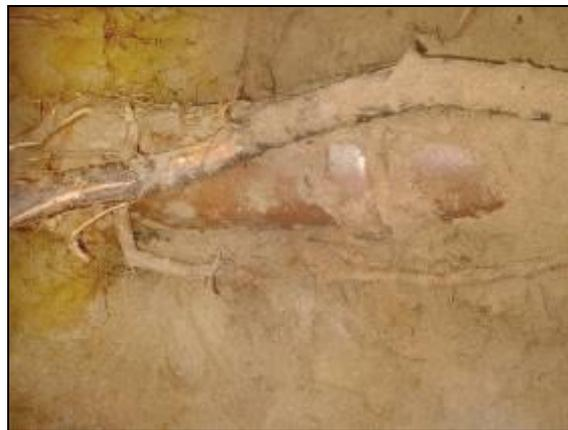
**Abb. 8:** Verholzte Wurzeln sind parallel zur Leitung gewachsen. Die Wurzeln haben hier einen Durchmesser von bis zu 0,2 m.
