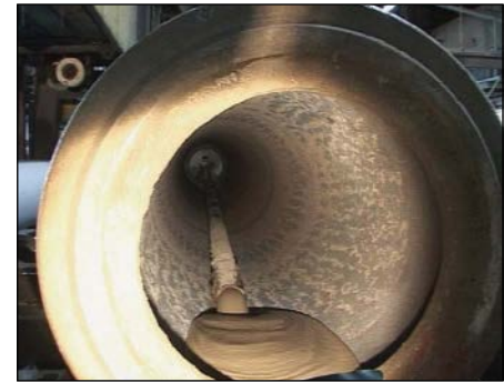
Bild 15.1: Einfüllen des Frischmörtels vor dem Rotationsschleudern
