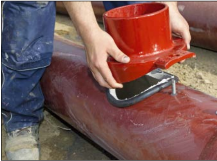
Bild 19.32: Eingelegter Dichtring und fixierte Halteschrauben
