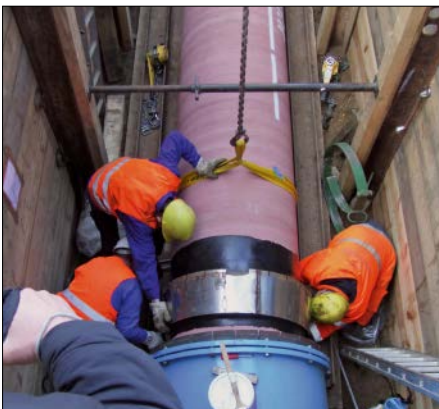
Bild 22.59: Montage des Stahlblechschutzkonus
