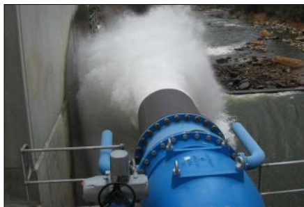
Bild 7.6.3: Ringkolbenventil DN 800, PN 10, mit Belüftung als Grundablassarmatur an einer Staumauer
