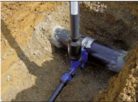
Bild 19.34: Anbohren eines duktilen Gussrohres mit Hilfe einer Anbohrarmatur
