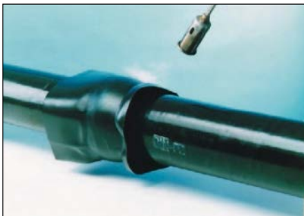
Bild 14.12: Applikation eines Schrumpfschlauches
