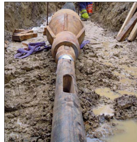
Bild 22.12: Zuggestänge mit Berstkopf
