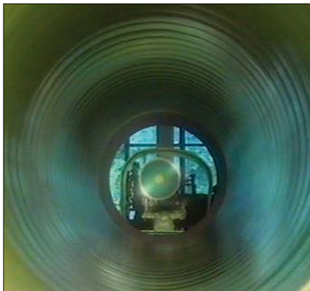
Bild 3.28: Aufbringen der PUR-Auskleidung mittels einer Lanze mit Rotationsdüse
