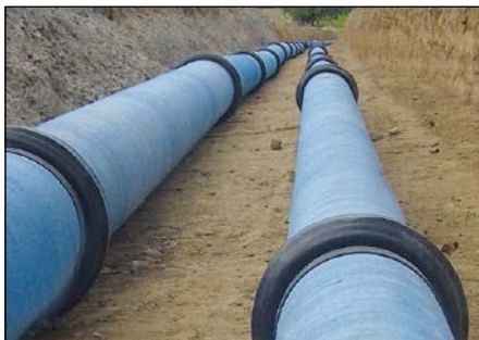
Bild 14.13: Duktile Gussrohre mit Zementmörtel-Umhüllung und Gummimanschette zum Schutz der Muffen-Verbindung
