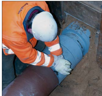
Bild 22.44: Anschluss für duktile Gussrohre
