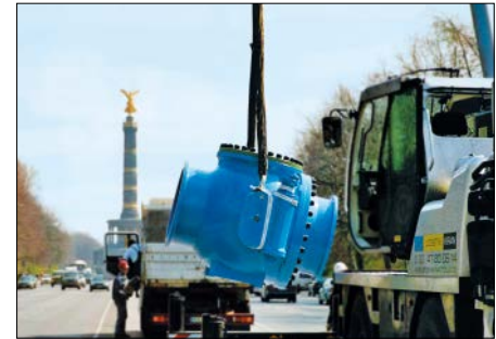
Bild 7.4.3-05: Kugelhahn DN 1000 für eine Abwasserdruck- leitung
