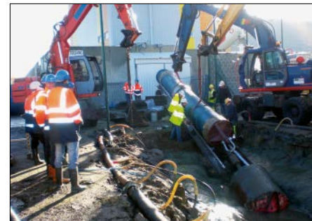
Bild 22.26: Räumwerkzeug mit Drehgelenk und Zugkopf
