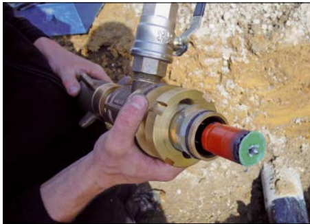
Bild 19.34: Anbohren eines duktilen Gussrohres mit Hilfe einer Anbohrarmatur
