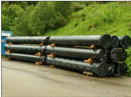
Bild 19.5: Auf Lagerhölzern abgesetzte duktile Gussrohre
