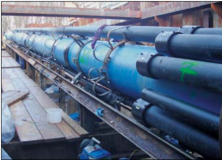
Bild 22.51: Abwasserleitung – geführte Rollenschellen
