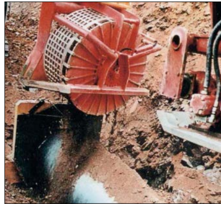
Bild 23.2: Überschüttung einer Turbinenleitung in felsigem Steilhanggelände
