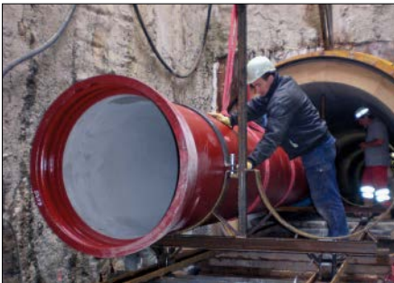
Bild 22.52: Abwasserleitung – Montage der Rollschellen
