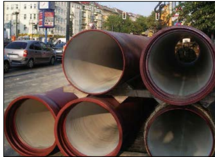
Bild 8.1: Duktile Kanalrohre mit der Steckmuffen-Verbindung TYTON®
