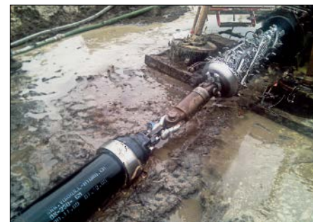
Bild 22.27: Positionierung des Drehgelenks zwischen Räumwerkzeug und Zugkopf
