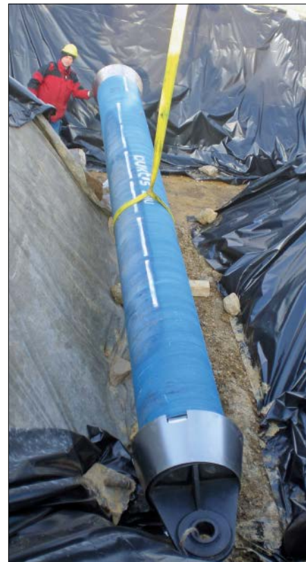
Bild 22.58: Rohr mit Zugkopf und Stahlblechkonus
