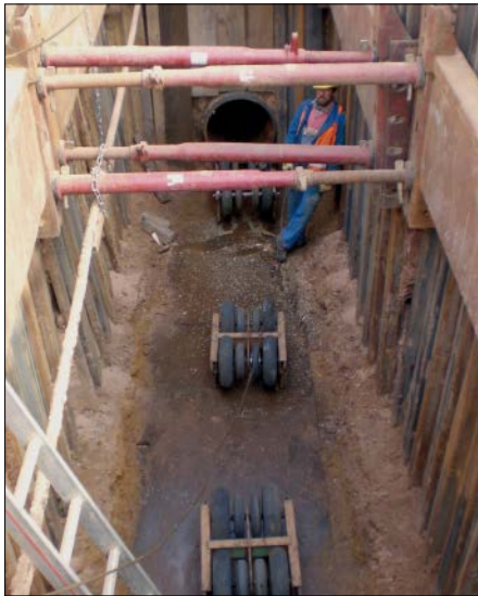
Bild 22.48: Startgrube
