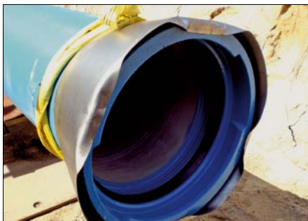
Bild 22.46: Stahlblechkonus zum Schutz der Muffe
