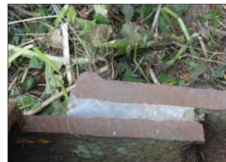
Bild 1.6: Aufgeschnittene Stemmuffen-Verbindung eines etwa 300 Jahre alten Gussrohres – Versorgungsleitung für die Wasserspiele des Schlossparks Kassel-Wilhelmhöhe mit dem Herkules-Denkmal; Weltkulturerbe der UNESCO seit Juni 2013 Quelle: mhk, Museumslandschaft Hessen Kassel
