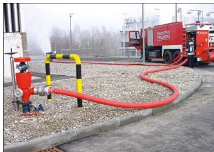
Bild 7.8.5-01: Industriehydrant für die Löschwasserversorgung in Industrieanlagen
