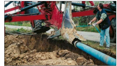
Bild 22.38: Pflug mit Aufweitkörper
