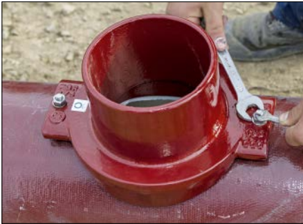
Bild 19.33: Aufgesetztes Sattelstück wird mit Halte- schrauben auf duktilem Gussrohr befestigt
