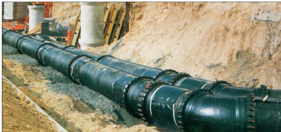
Bild 23.5: Kühlwasserleitung des Kernkraftwerks Philippsburg
