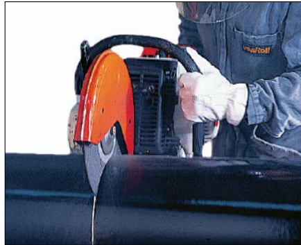
Bild 19.17: Trennschnitt an einem Rohr
