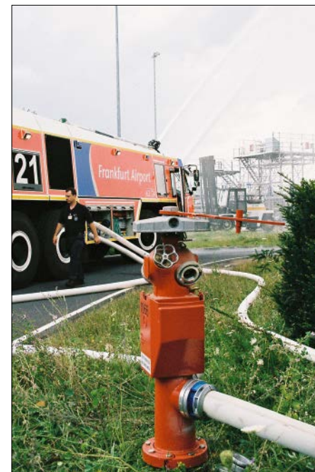
Bild 7.8.5-02: Industriehydrant für die Löschwasserversorgung bei Flughäfen
