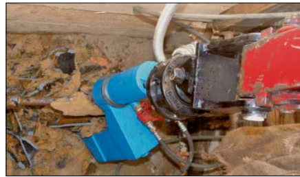
Bild 22.18: Hydraulischer Rohrknacker
