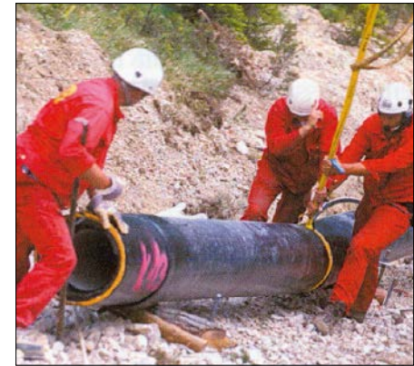
Bild 23.3: Einbau mit Hubschrauberunterstützung
