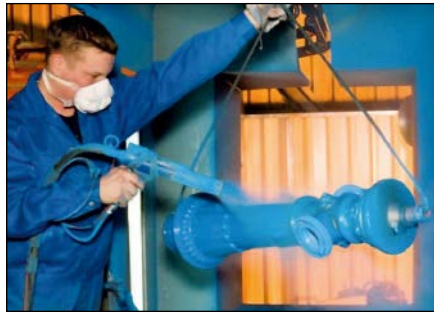
Bild 7.2.1-04: Elektrostatisher Epoxidharz-Pulver-Auftrag mit Sprühpistole
