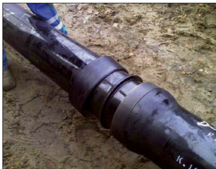
Bild 22.5: Formschlüssige Steckmuffen- Verbindung HYDROTIGHT
