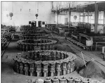
Bild 3.12: Blick in die Gießhalle mit einem Rohrgießkarussell
