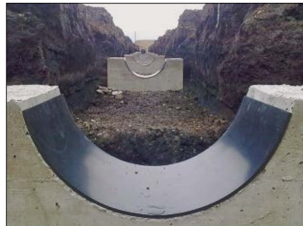
Bild 19.47: Betonauflassers mit Neopren- auflage für duktile Gussrohre
