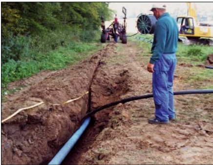
Bild 22.41: Eingepflügte Rohrleitung
